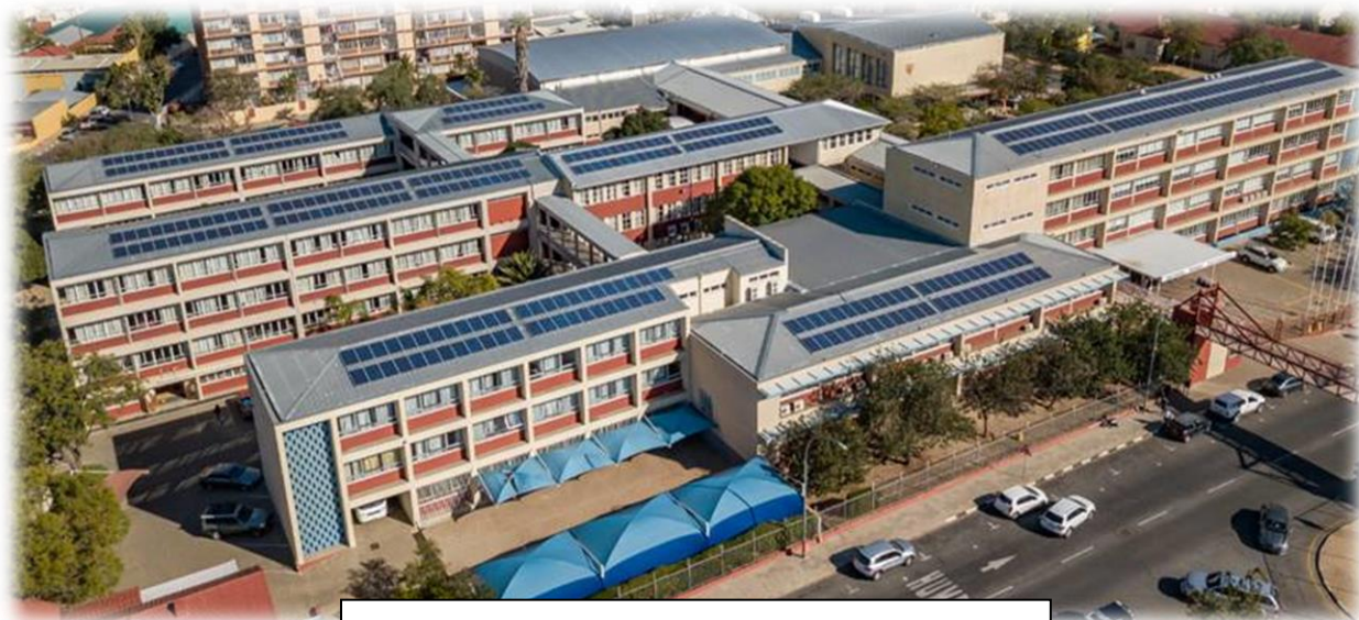
Deutsche Höhere Privatschule Windhoek – 104 kWp
