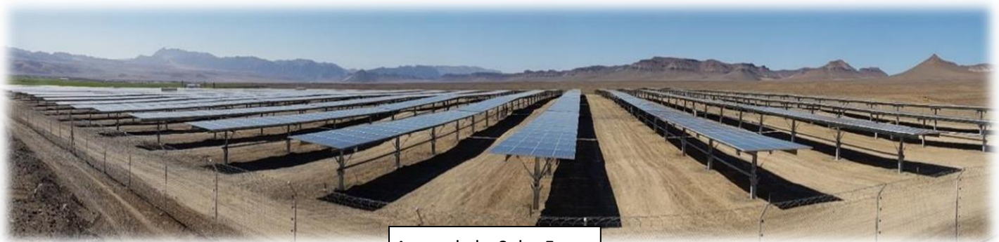
Aussenkehr Solar Farm
