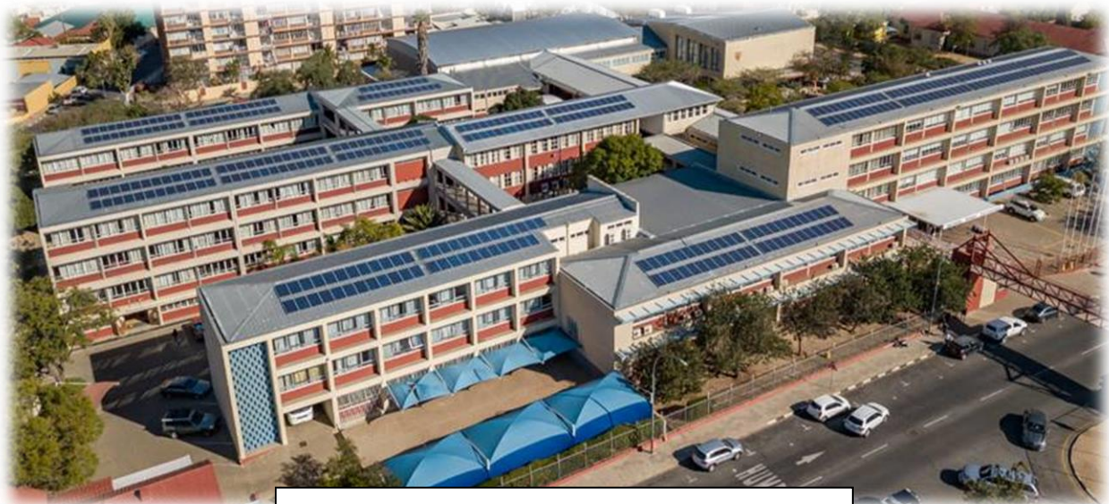
Deutsche Höhere Privatschule Windhoek – 104 kWp
