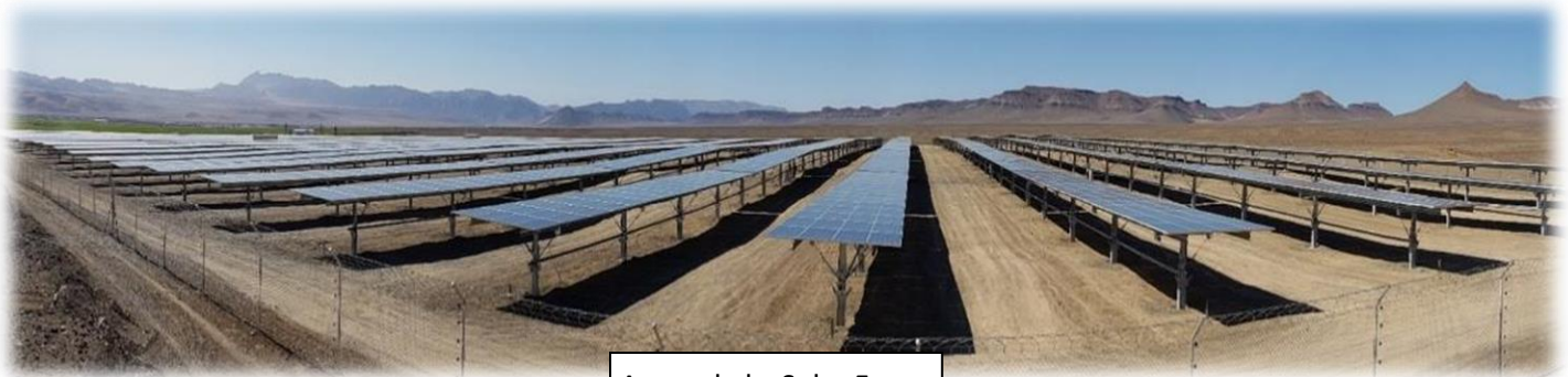
Aussenkehr Solar Farm
